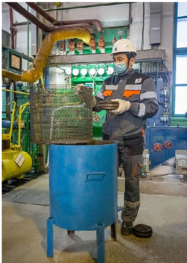
Использование для чистки клапанов раствора кальцинированной соды увеличило срок их эксплуатации и сократило время простоев оборудования
